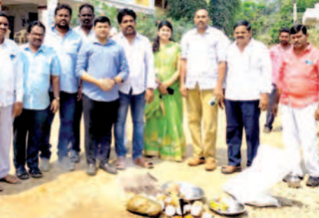
రోడ్డు నిర్మాణ వసులకు శంకుస్థాపన చేస్తున్న మున్సిపల్ చైర్మన్ రంగాపురం రాఘవేంద్ర.
